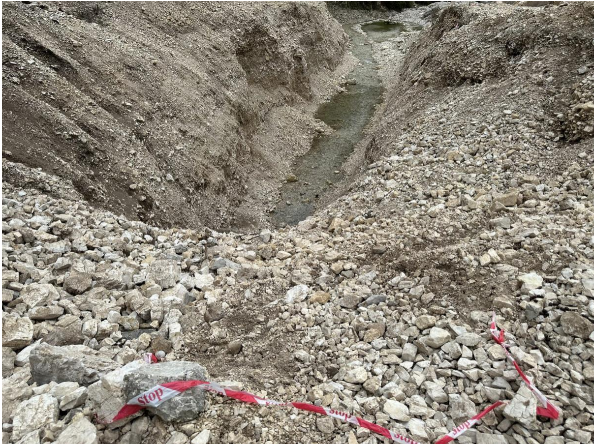
Figura 7: Kanali 5-6 metra i thellë i marrjes së ujit në anën e majtë të Shushicës © U. Eichelmann
