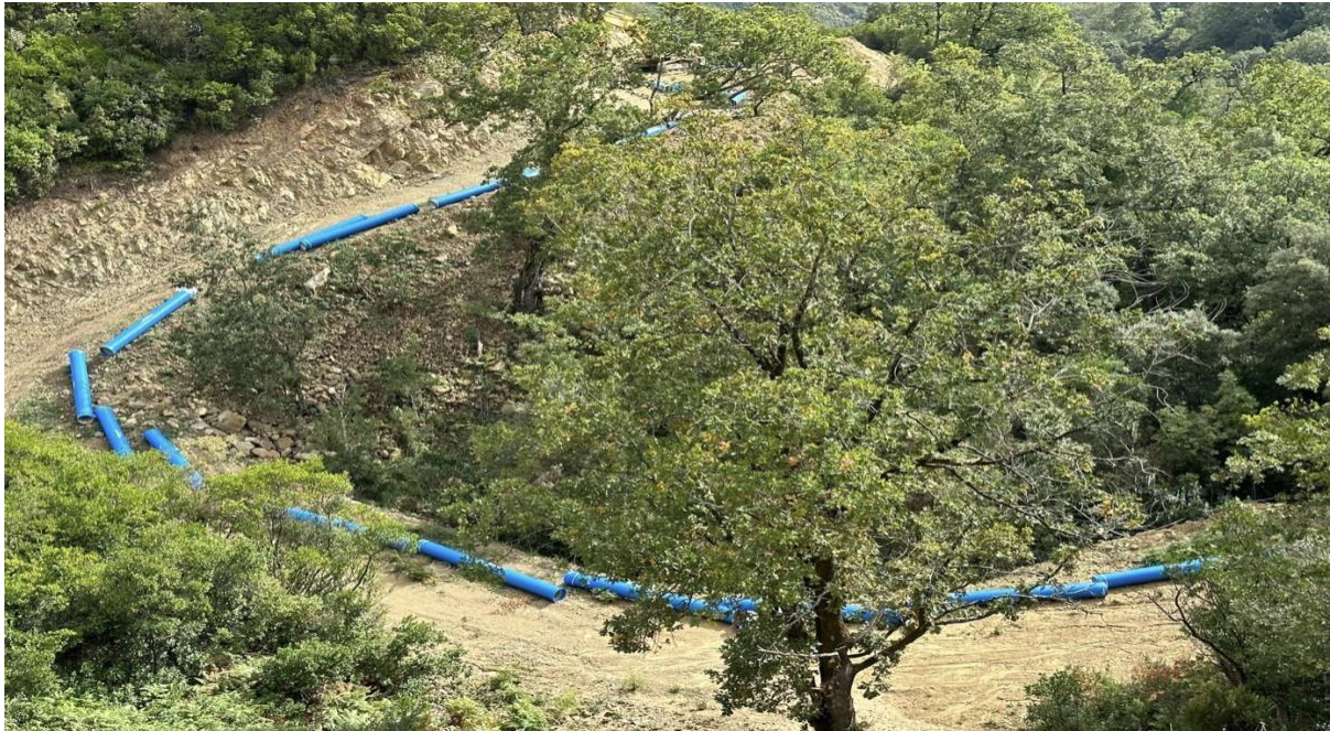
Figura 6: Shpërndarja e tubave përgjatë gjurmës së tubacionit © U. Eichelmann
