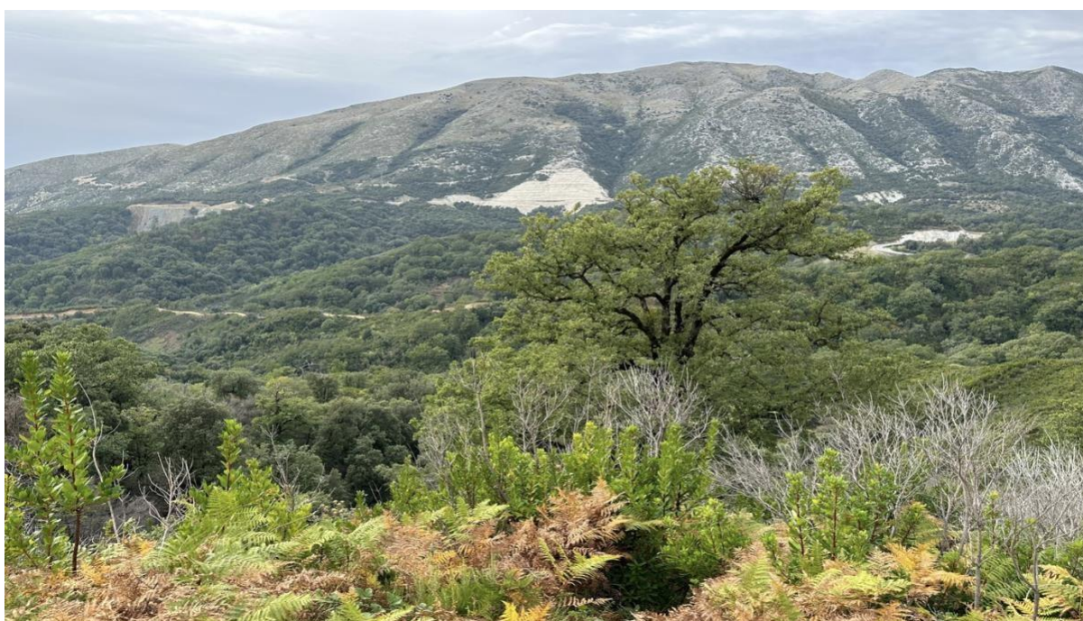
Figura 5: Ndërtimi i gjurmës së tubacionit në mes të pyllit të lisit © U. Eichelmann
