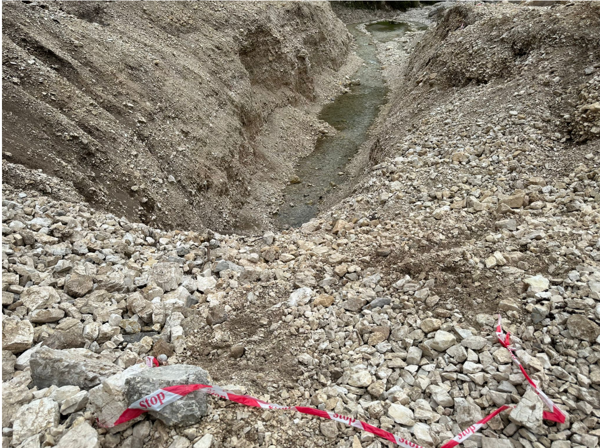
Figure 5: Kanali 5-6 metra i thellë i prurjes në anën e majtë të lumit Shushica © U. Eichelmann
