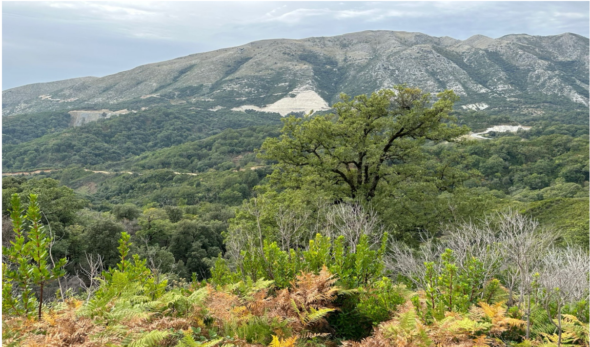
Figura 3: Ndërtimi i gjurmës së gazsjellësit në mes të pyllit të dushkut © U. Eichelmann
